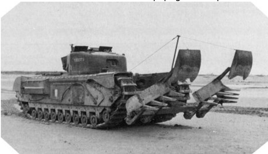
Bullshorn Plough : Le Bullshorn Plough était un char doté d'un rabet prévu pour excaver la terre devant lui. Cela lui permettait lors de son passage de faire exploser et de rendre inoffensives les mines présentes.
